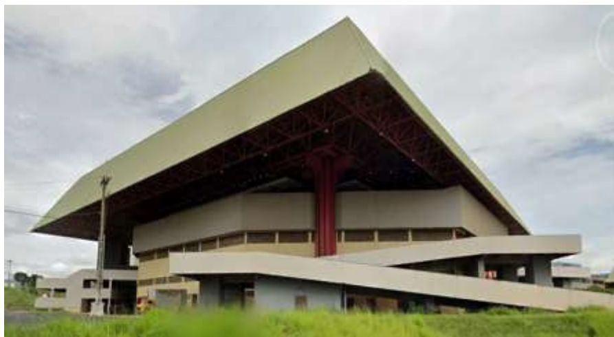
Consorcio G12 Ingeniería: Obra del Gimnasio de Deportes de Goiânia para 12 mil personas, junto al CRISA.
